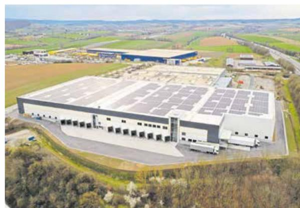
Ein Kundenprojekt: Auf dem Dach der Logistikhalle sind 5.000 PV-Module montiert.
